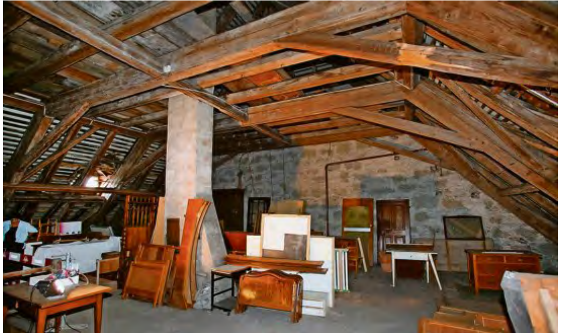
Soll als Eventraum genutzt werden: Der Dachstock im Gästehaus Kreuz. Er wird nun in Absprache mit der Denkmalpflege saniert.
