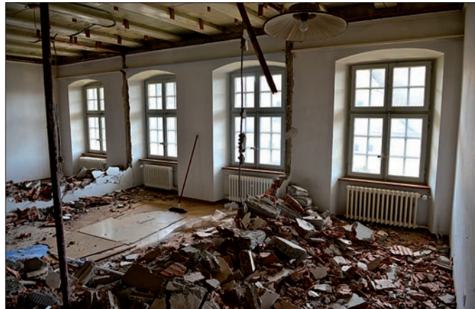
Hier entstehen Hotelzimmer. (Bild: zvg)
