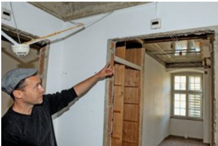
Der Restaurator zeigt, wo einst neue Zwischenwände eingebaut wurden. Diese werden nun entfernt.
